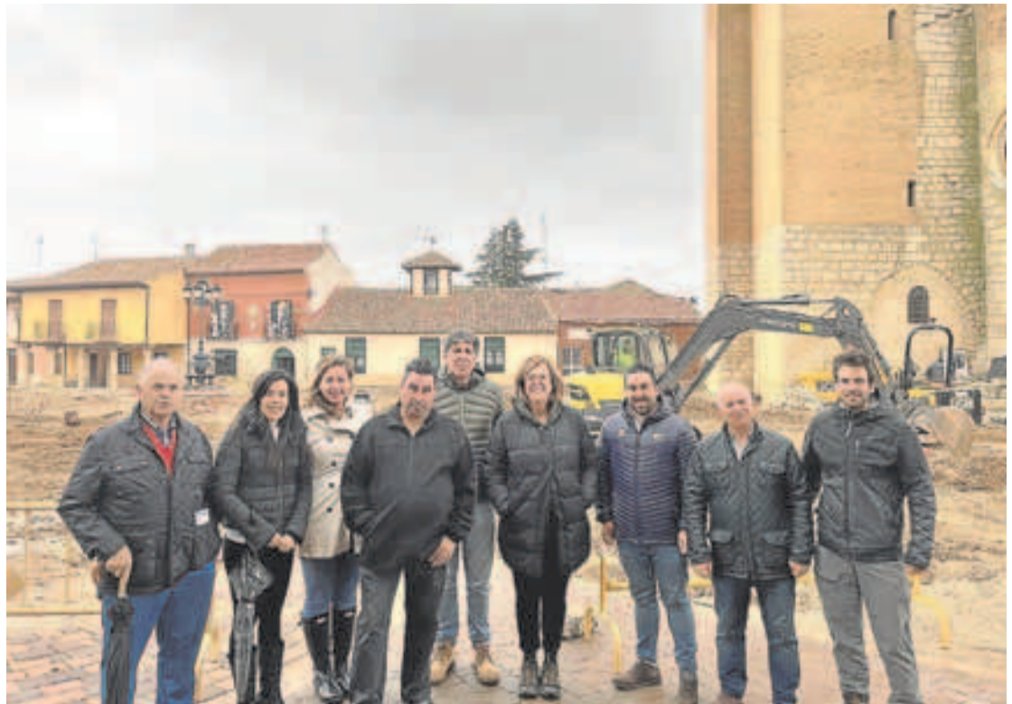
Visita a las obras de la plaza de Becerril. EL NORTE
